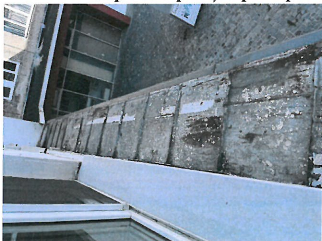
Copertină planșeu peste parter din tablă zincată deteriorată
