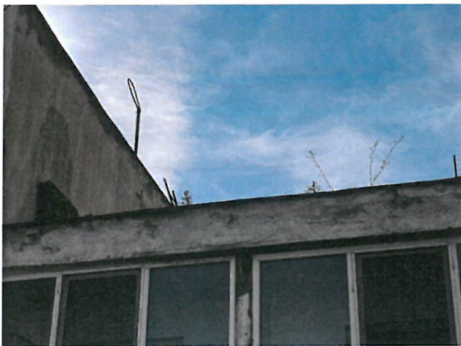
Șorțuri din tablă deteriorate
