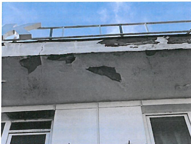
Beton explodat datorită ciclurilor îngheț-dezgheț
