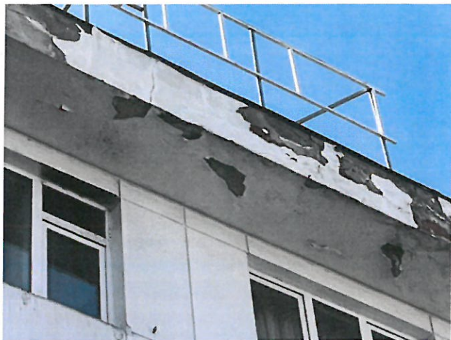
Tencuieli deteriorate
