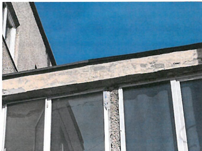
Șorțuri din tablă deteriorate
