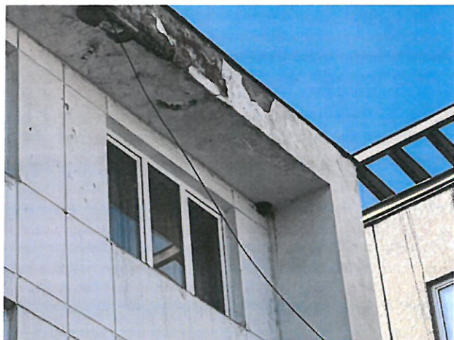
Beton explodat datorită ciclurilor îngheț-dezgheț
