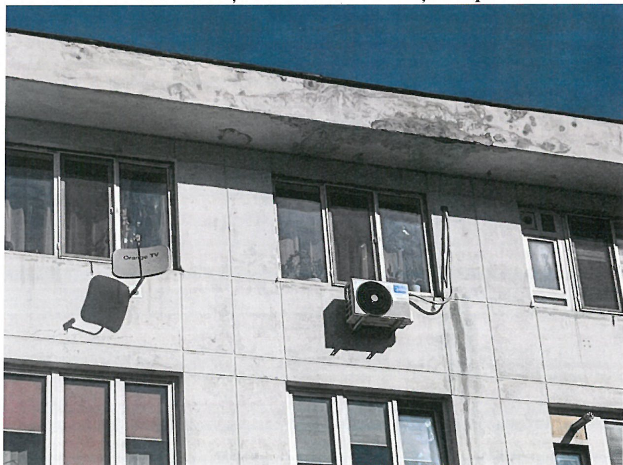
Atic – cornișă deteriorat de infiltrații de apă
