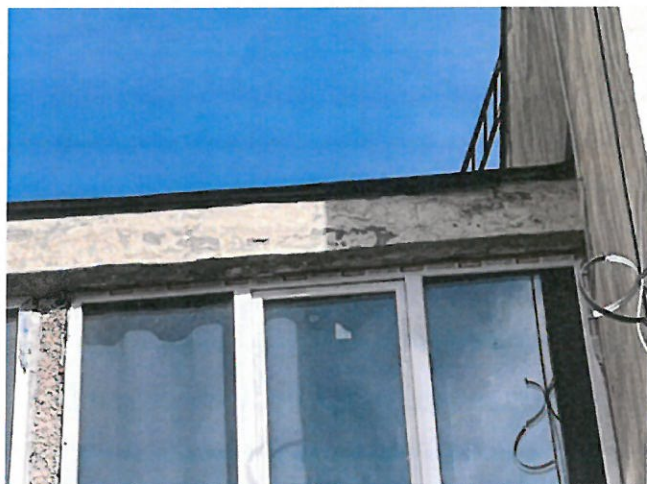
Șorțuri din tablă deteriorate
