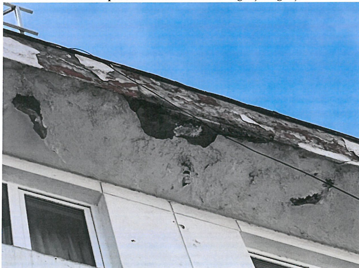
Beton explodat datorită ciclurilor îngheț-dezgheț
