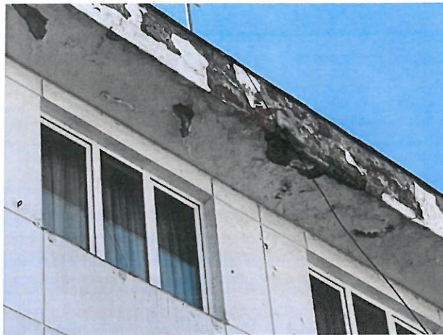
Tencuieli deteriorate
