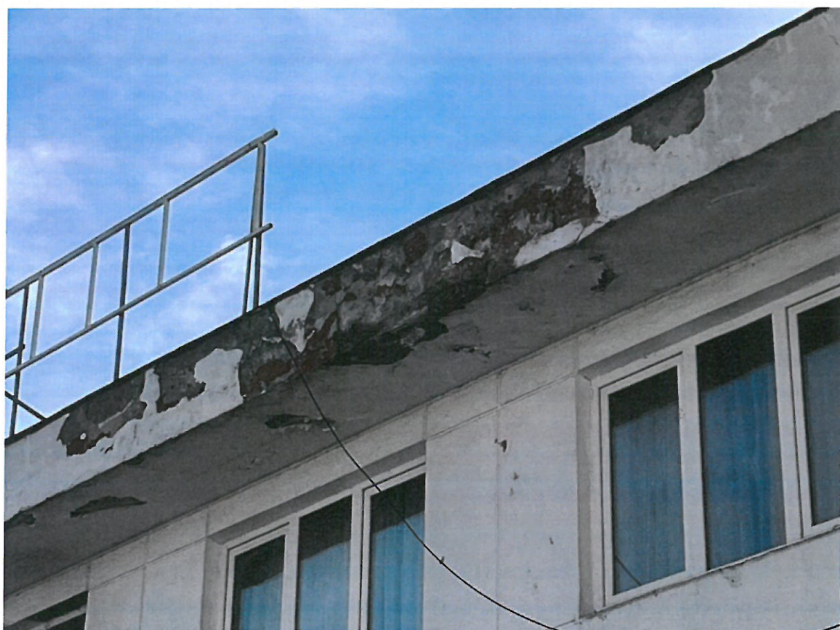
Copertină planșeu peste parter din tablă zincată deteriorată
