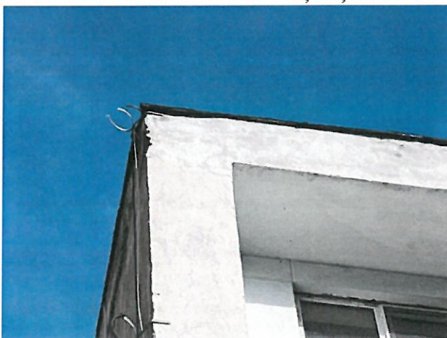
Șorțuri din tablă deteriorate
