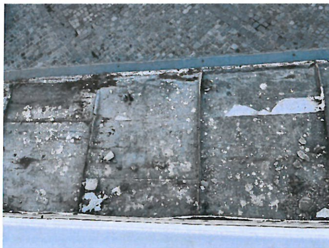
Copertină planșeu peste parter din tablă zincată deteriorată
